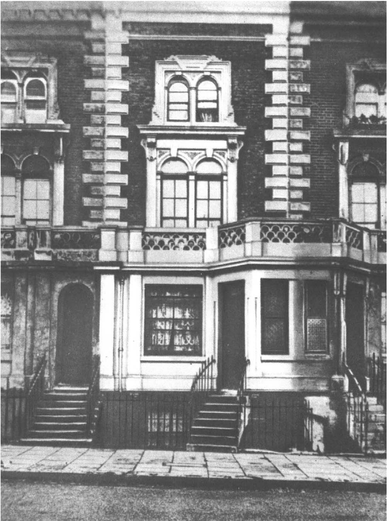
Дом в Лондоне (9, Графтен-террес, Мейтленд-парк, Хаверсток-Хилл), в котором жил Маркс с октября 1856 по 1868 год
